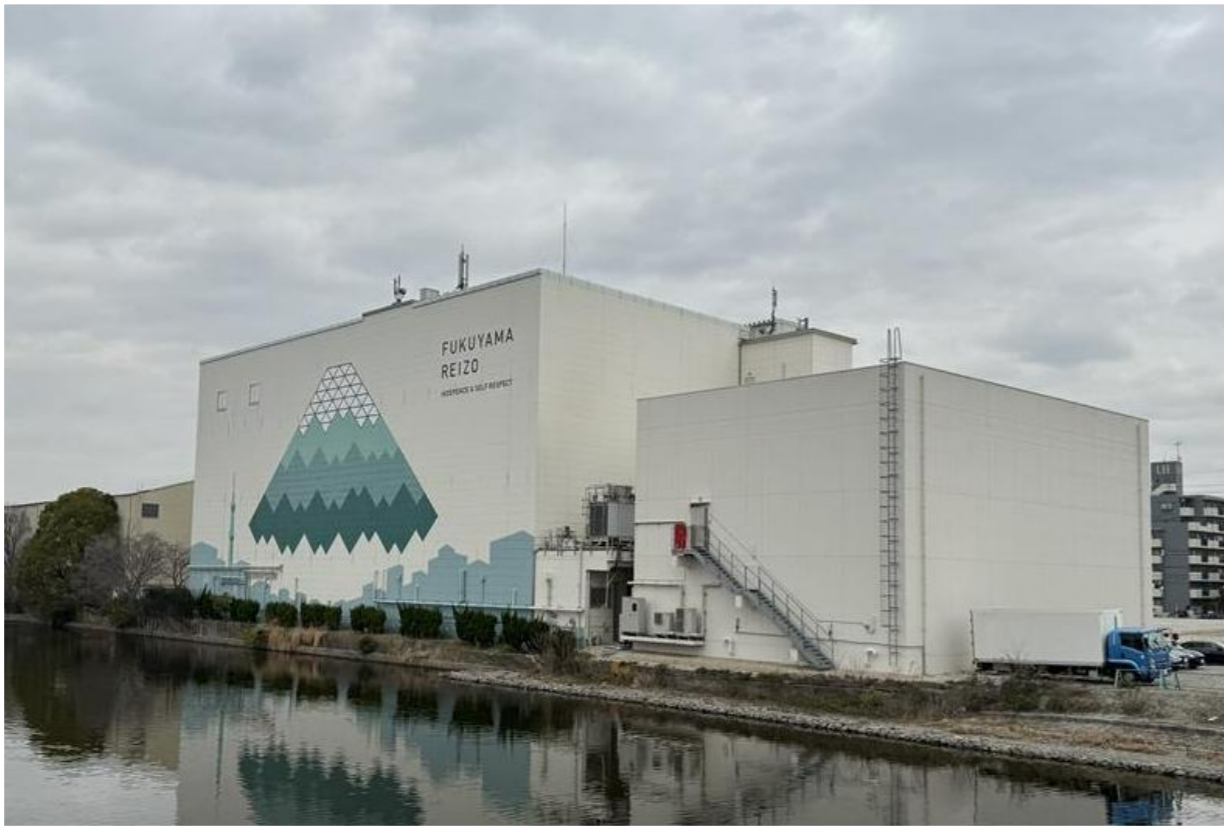
Fukuyama Reizo Co., Ltd. Nakagawa Center - Exterior View
