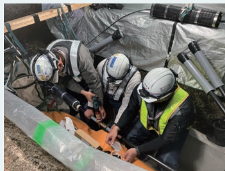
特別高圧ケーブルの接続作業
