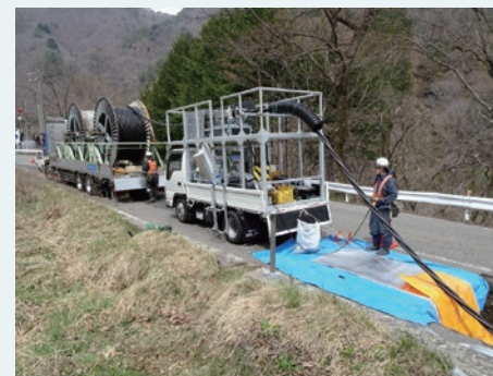
地下ケーブルの延線・接続作業
