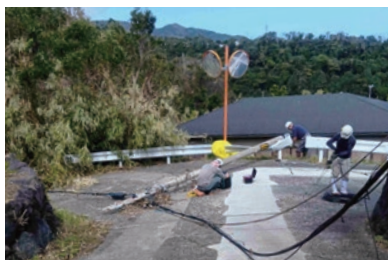
電柱の復旧作業
