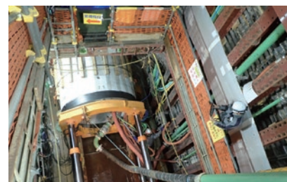
世界最長クラスを達成した、非開削工事 (トンネル工事)
