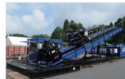
弧状推進工法(アースシャトル工法)
